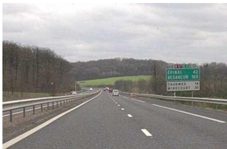
N57 au niveau de Bayon (© France Autoroutes)
