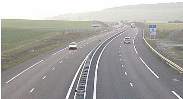
A5 à l'ouest de Troyes (© France Autoroutes)
