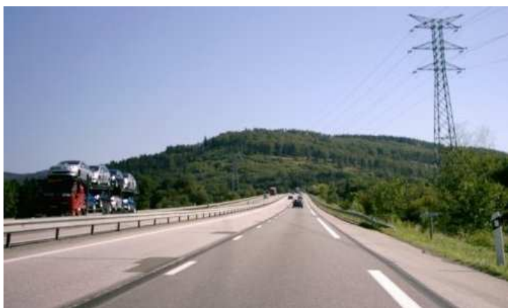
RN57 au niveau de Pouxieux (© France Autoroutes)
