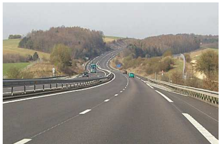
A4 au niveau de Verdun (© France Autoroutes)
