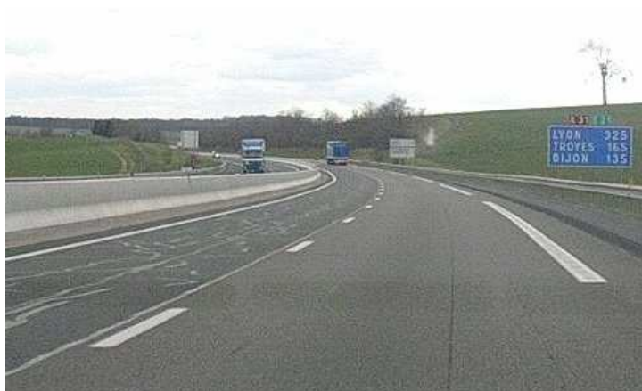
A31 après l'échangeur de Bulgnéville (© France Autoroutes)
