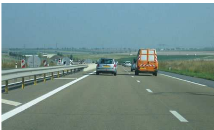
A34 au niveau de Cernay-les-Reims (© France Autoroutes)
