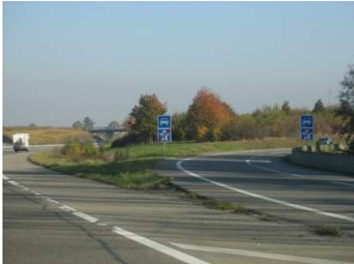
Echangeur avec la voie express D500.
