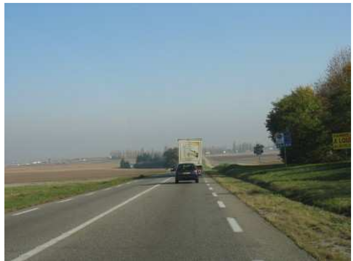
RN422, assurant la continuité de l'autoroute.
