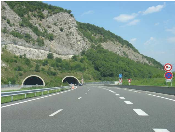
Tunnel après la sortie 12.
