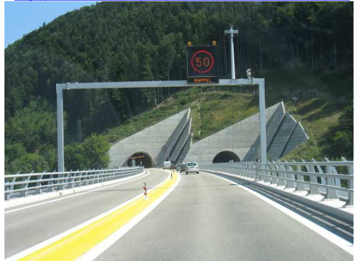
Entrée du tunnel de Sinard, à double-sens.
