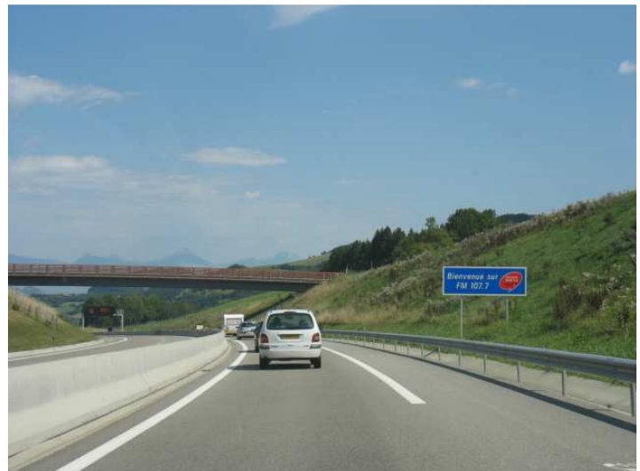
Descente à 2+1 voies, avec bande d'arrêt d'urgence inexistante dans le sens montant et très réduite dans le sens descendant.
