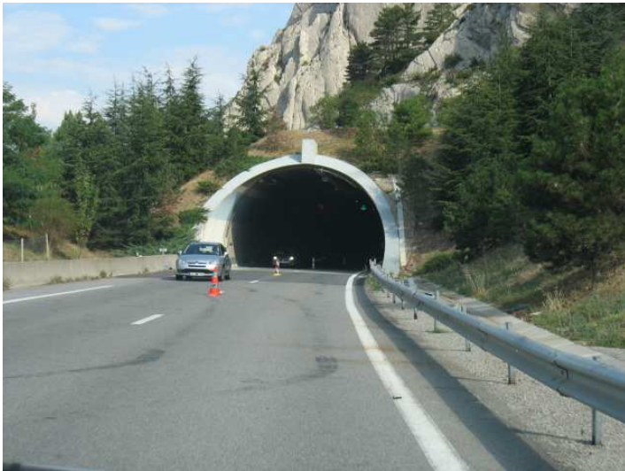
Tunnel de la Baume (provisoirement à double-sens)
