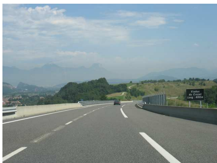
Viaduc du Crozet.
