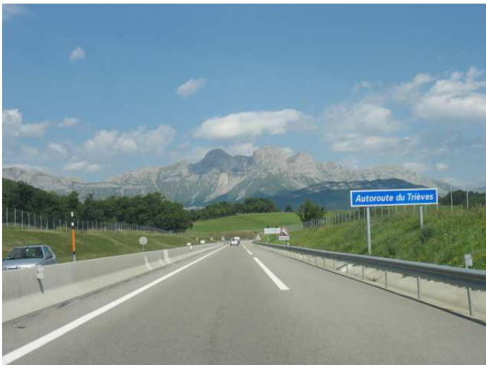
Premiers mètres de l'A51 nord, à caractéristiques réduites, et vue sur le Trièves.
